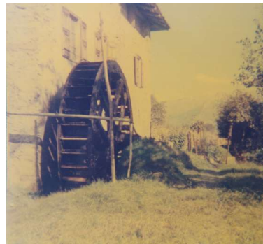
Canale sopraelevato in calcestruzzo; la ruota era molto grande e veniva mossa dal basso
